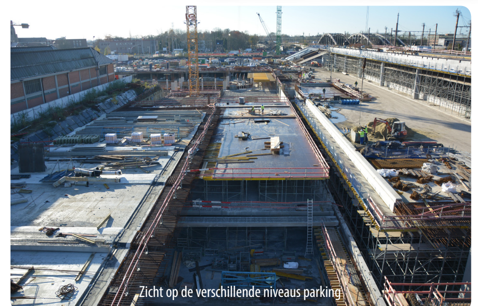
De laatste betonstorten voor de dakplaat van de parking
